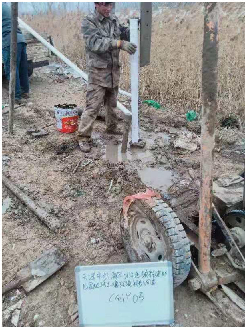
图 4-3 建井过程照片
