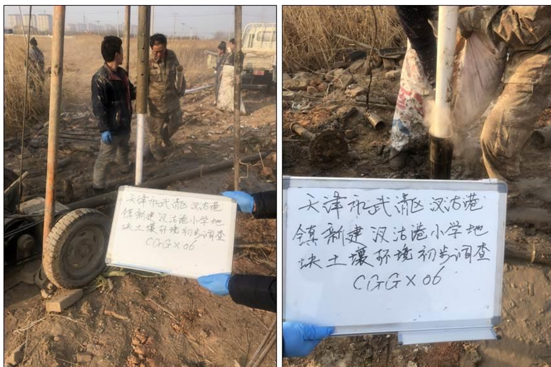
图 4-4 建井过程照片
